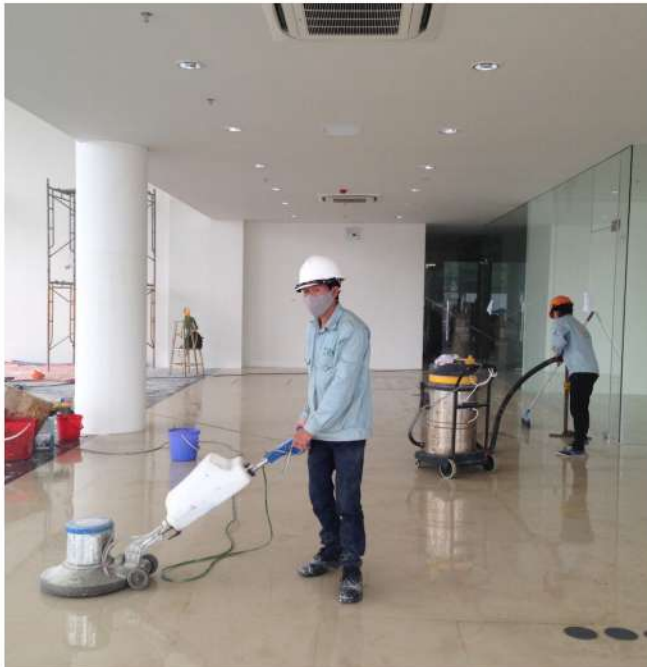
Vệ sinh sau xây dựng Cleaning after construction
